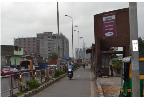
05-SPACING OF LIGHT POLES.JPG
